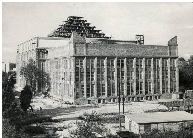
Budowa gmachu głównego przy al. Niepodległości, 1954 rok
